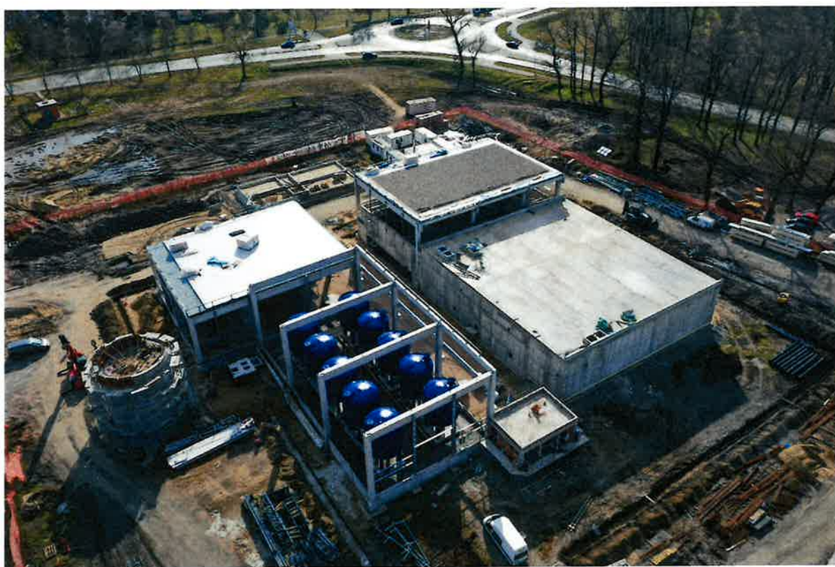
Слика 5. - Фабрика воде у изградњи
