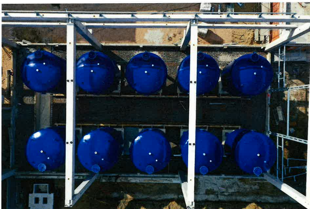
Слика 6. - Фабрика воде у изградњи
